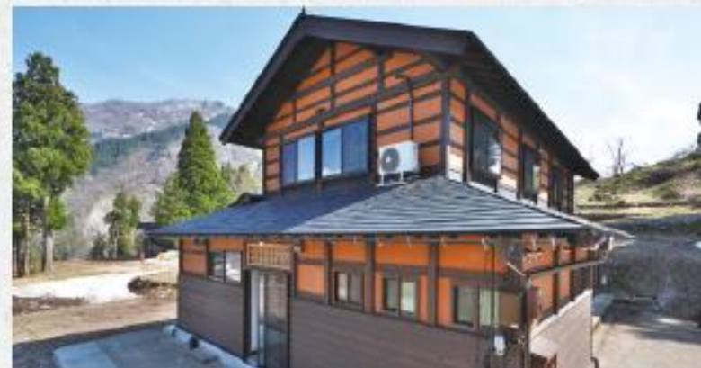
相倉ワーケーションセンター（平村第二研修所）
